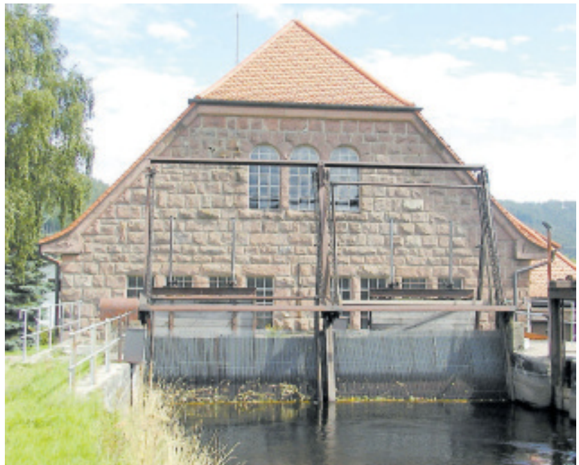
Die Wasserkraftanlage „Neues Werk“ in Baiersbronn ist bereits seit 1923 in Betrieb. Die Turbinen wurden 1955 erneuert. Bilder: Gemeindewerke Baiersbronn
